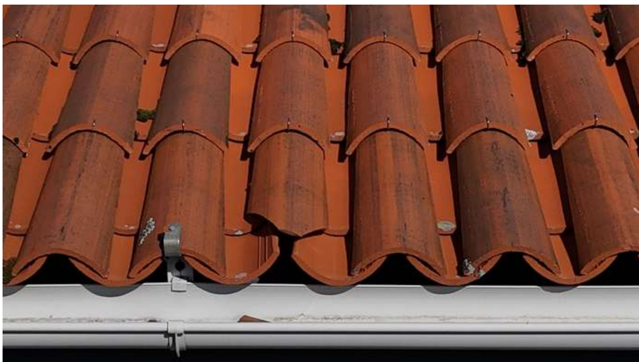
Cubierta con tejas rotas
