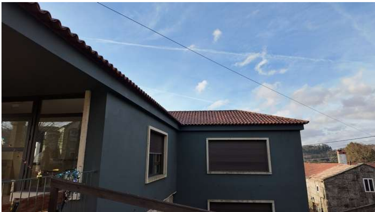
Zona de cubierta sin canalones ni bajantes
